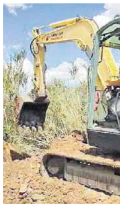
Reparación en Cártama.
